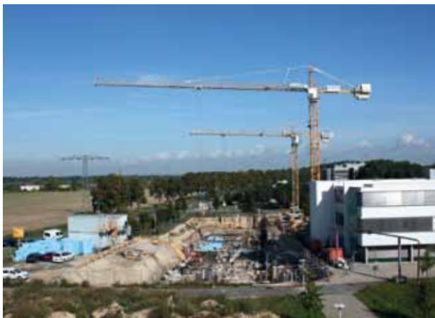
Beginn der Bauarbeiten zur zweiten Ausbaustufe des Fraunhofer IAP, 22.9.2010.
